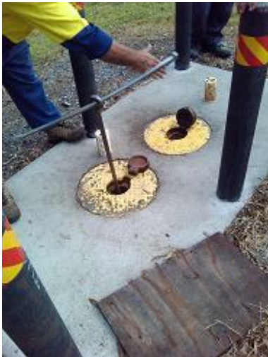
Fill test bed pipe
